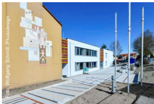
Die frisch sanierte Max-Beckmann-Schule in Worzeldorf.
